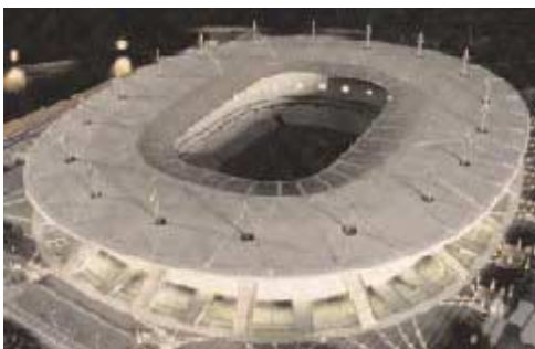
Dakbedekking "Stade de France"
